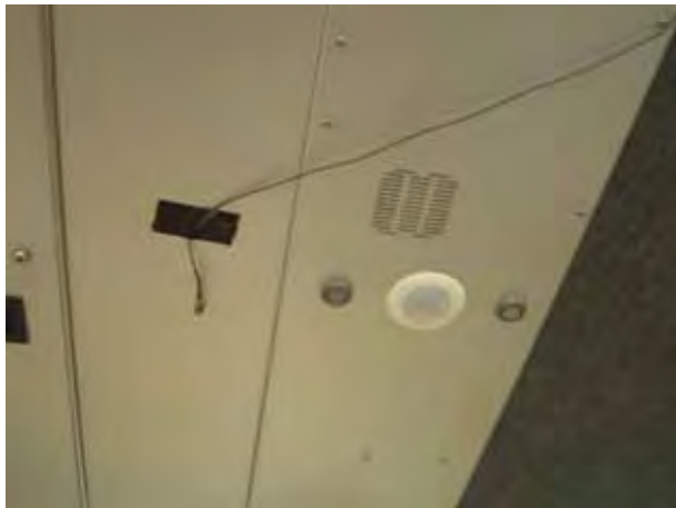
加速規(車廂天花板) 量測發聲源之異常共振
